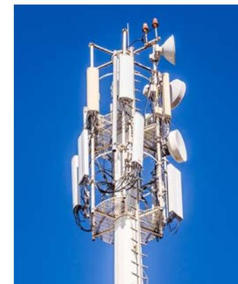
*Mobilfunkmast einer Basisstation mit rechteckigen Mobilfunkantennen und runden Richtfunkantennen*
